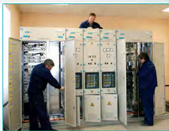
Монтаж оборудования на подстанции "Осиновая роща-2" ПС 110/10/10 кВ (Санкт-Петербург)
