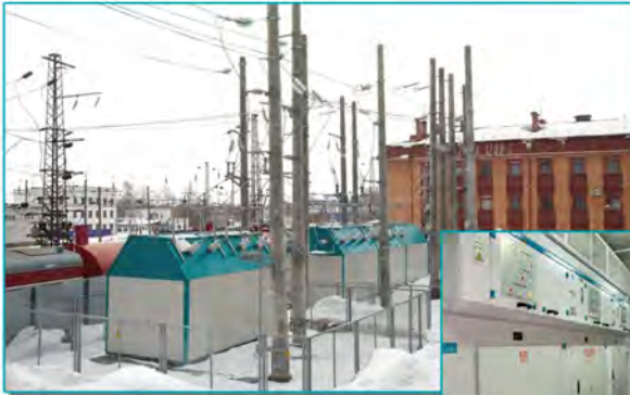
Пункт группировки модульного типа ПГ-М-3,3/27,5
