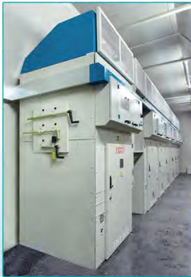
1С-УЗССП-3,3 Модуль пункта группировки с ячейкой устройства защиты станции стыкования полупроводниковый.
