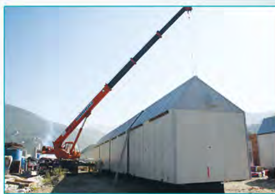
Монтаж тяговой подстанции "Горная" (Совмещенная (автомобильная и железная) дорога Адлер - горноклиматический курорт "Альпика-Сервис")
