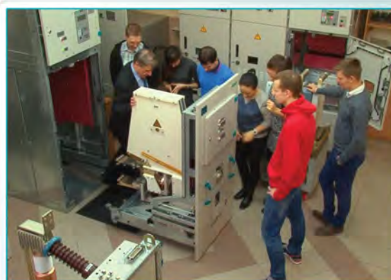
Практические занятия со студентами на учебной тяговой подстанции в ПГУПС (Санкт-Петербург)
