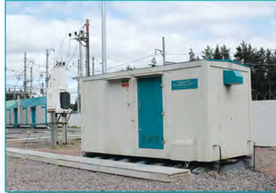
Модуль дизель-генератора Выпускается в типоразмерах модулей 6 м. Мощность генератора 100 кВт (125 кВ·А) Номинальное напряжение генератора 380/220 В или 220/127 В. Нейтраль – изолированная или глухозаземленная. Продолжительность непрерывной работы без дозаправки – 24 часа. Вместимость топливного бака 800 л. Расход при 100% нагрузке 29,4 л/ч.
