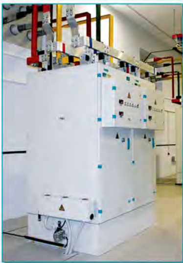
Блок функциональный тягового выпрямителя БЛ-В-МПП-Д-3,15к-3,3к-УХЛ4
