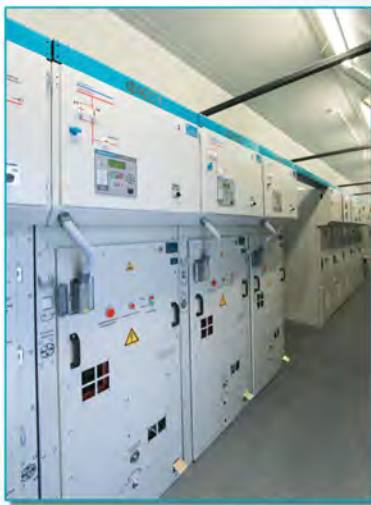
Функциональные блоки устройств комплектных распределительных постоянного тока до 3300 В Одностороннее обслуживание, внутренняя установка. Выполнены на базе шкафов серии "КВ-3,3" или аналогичных. Ток главных цепей блока до 6300 А. Количество ячеек в блоке – до 4 шт.
