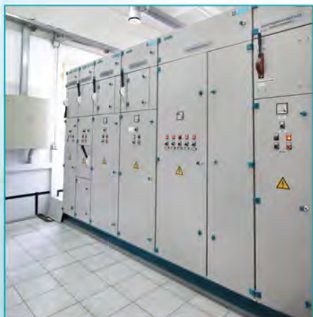
Низковольтное комплектное устройство Одностороннее обслуживание, номинальный переменный ток главных цепей до 2500 А, номинальное напряжение переменного тока до 0,66 кВ, номинальный постоянный ток главных цепей до 630 А, номинальное напряжение постоянного тока до 230 В.
