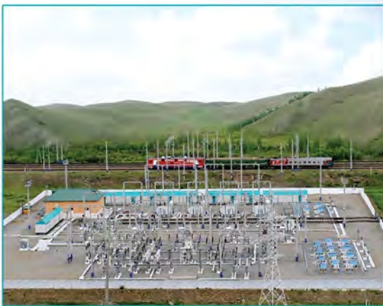
Подстанция комплектная тяговая переменного тока 2х25 кВ Номинальное питающее (вводное) напряжение переменного тока 110; 220 кВ. Номинальное напряжение отходящих линий переменного тока для питания тяговых потребителей 2х25 кВ.
