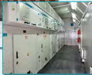
Пункт группировки модульного типа ПГ-М-3,3/27,5
