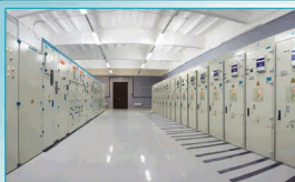
Машинный зал тяговой подстанции постоянного тока "Лейпасуо" (Октябрьская железная дорога)
