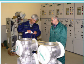
Шеф-монтаж оборудования на тяговой подстанции переменного тока "Вохтога" (Северная железная дорога)
