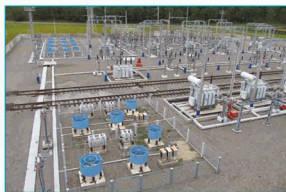
Устройство фильтрации и компенсации реактивной мощности 27,5 кВ переменного тока
