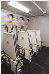
Высоковольтный отсек поста секционирования постоянного тока ПС-3,3-2
