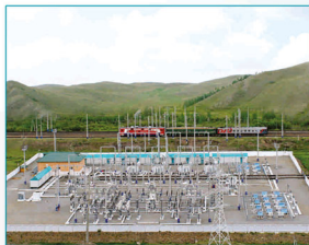
Подстанция комплектная тяговая переменного тока 2x25 кВ Номинальное питающее (вводное) напряжение переменного тока 110, 220 кВ. Номинальное напряжение отходящих линий переменного тока для питания тяговых потребителей 2x25 кВ.
