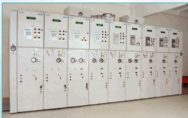
Комплектное распределительное устройство переменного тока на напряжение 27,5 кВ серии "K-200" Одностороннего обслуживания, внутренней установки, с элегазовой изоляцией, с использованием вакуумных выключателей серии ЗАН и трехполюсных разъединителей с током главных цепей до 4000 А.
