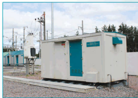
Модуль дизель-генератора Выпускается в типоразмерах модулей 6 м. Мощность генератора 100 кВт (125 кВт-А) Номинальное напряжение генератора 380/220 В или 220/127 В. Нейтраль – изолированная или глухозаземленная. Продолжительность непрерывной работы без дозаправки – 24 часа. Вместимость топливного бака 800 л. Расход при 100% нагрузке 29,4 л/ч.
