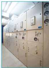
Функциональные блоки распределительного устройства 35 кВ Одностороннего обслуживания, внутренней установки. Выполнены на базе ячеек серии "К-201" или аналогичных. Ток главных цепей блока до 2500 А. Количество шкафов в блоке – до 6 шт.
