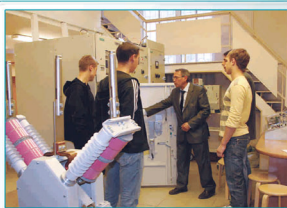
Практические занятия со студентами на учебной тяговой подстанции в ПГУПС (Санкт-Петербург)
