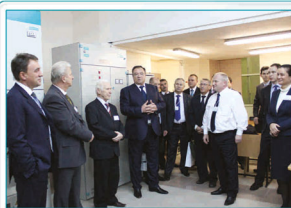
Открытие учебной тяговой подстанции в ПГУПС с современным электрооборудованием, изготовленным ООО "НИИЭФА-ЭНЕРГО" (Санкт-Петербург)
