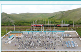
Тяговая подстанция переменного тока 2х25 кВ "Булак" (Забайкальская железная дорога)
