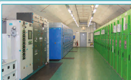
Машинный зал на станции метрополитена "Международная" (Санкт-Петербург)
