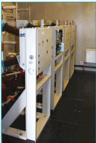
Высоковольтный отсек поста секционирования переменного тока ПСК-27,5-2
