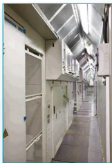
Функциональные блоки распределительного устройства 2х25 кВ Одностороннего обслуживания. Выполнены на базе ячеек серии "ТС-2х25", "К-200" или аналогичных. Ток главных цепей ячеек блока до 1250 А. Количество ячеек в блоке – до 3 шт.
