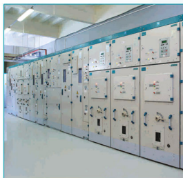
Функциональные блоки устройств комплектных распределительных постоянного тока до 3300 В Одностороннего обслуживания, внутренней установки. Выполнены на базе ячеек серии "КВ-3,3" или аналогичных. Ток главных цепей блока до 6300 А. Количество ячеек в блоке – до 4 шт.
