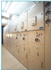
Комплектное распределительное устройство на напряжение 35 кВ серии "К-201"
