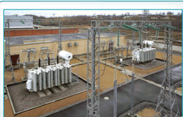
Подстанция "Осиновая Роща-2" ПС 110/10/10 кВ (Санкт-Петербург)
