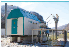
Устройство продольной компенсации для системы тягового электроснабжения переменного тока напряжением 25 кВ
