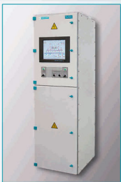
Шкаф управления подстанцией
