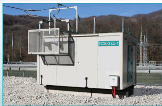
Пост секционирования переменного тока ПСК-27,5-1 Северо-Кавказской железной дороги
